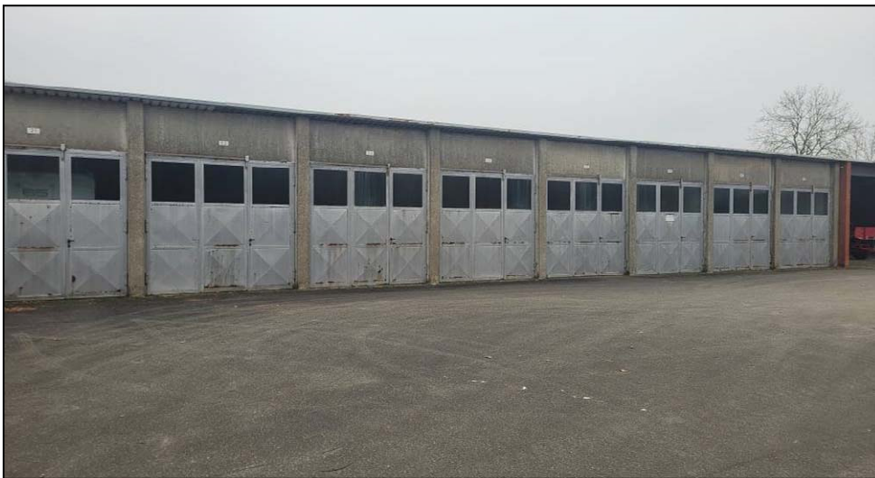
Abb. 4: Zum Abriss vorgesehene Garagenanlage. 15.01.2023 © Büro Mehring/J. Troschke
