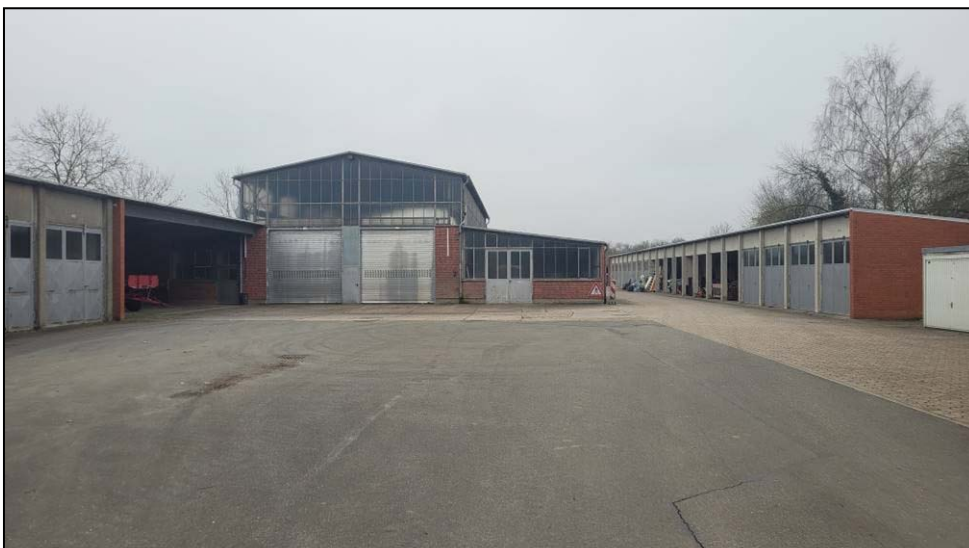
Abb. 5: Zum Abriss vorgesehene Garagenanlagen (links und rechts) sowie die ehemalige Werkstatt (Mitte), deren Erhalt geplant ist. 15.01.2023 © Büro Mehring/J. Troschke
